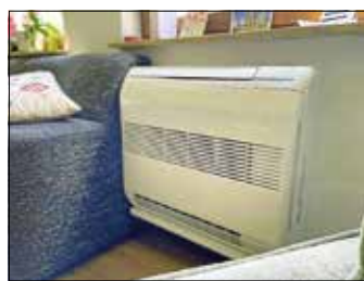
Sogenannte Klimasplitgeräte können neben dem Kühlen auch zum Heizen eingesetzt werden Foto: LEA
